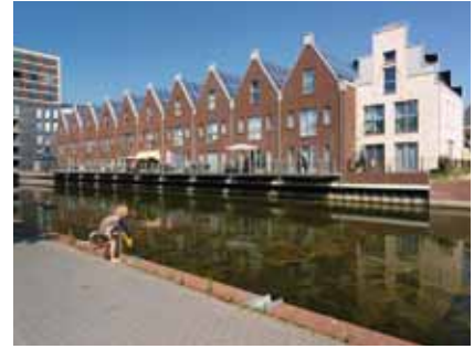
Nieuwbouw en Herstructurering
